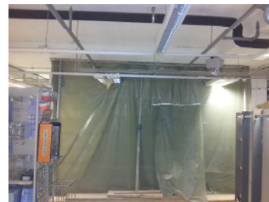
Staubwand im Do IT Migros
