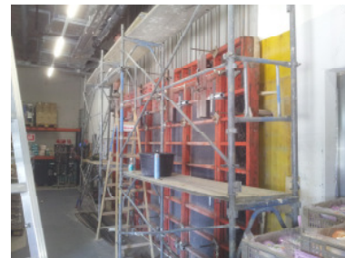
Wandschalung im Migros Lager
