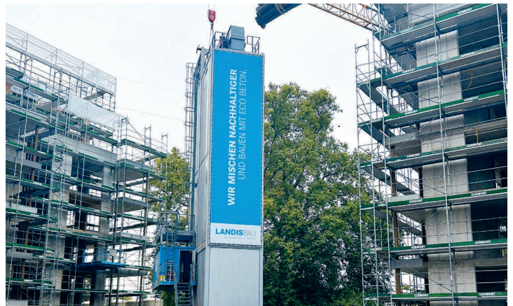
Mobile Betonanlage in Cham
